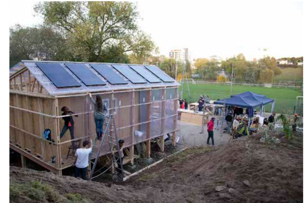
Le bloc des sanitaires en cours de construction en octobre 2016. Cette structure, dessinée par des architectes de l'association Quatorze, a été également construite par des habitants du bidonville et des bénévoles © FAP, 2016
