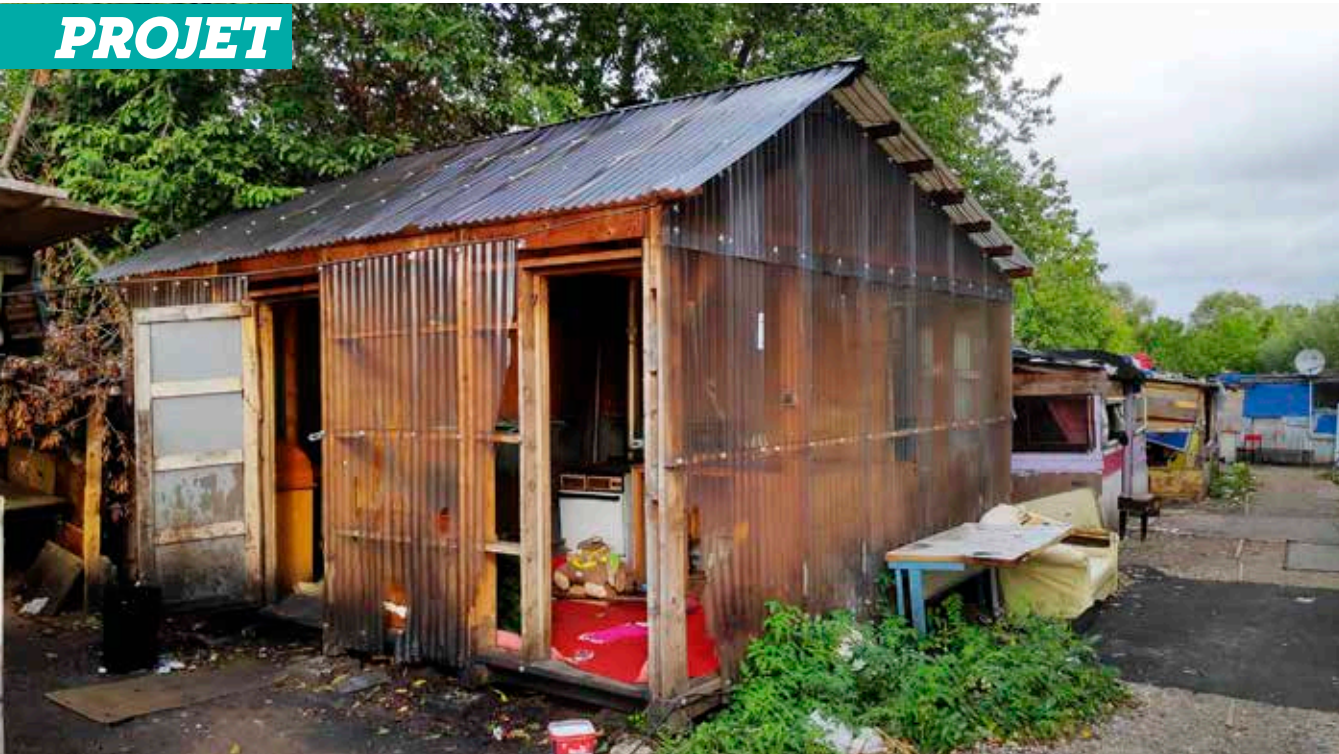
L'espace cuisine réalisé à la fin de l'été 2016, dessiné par des architectes de l'association Quatorze et construit par des habitants du bidonville et des bénévoles © J.-B. Daubeuf, 2019
